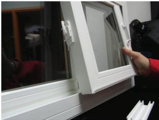
3. Deslice el sash a la posición abierta y levántela firmemente en la dirección vertical e incline la parte de abajo asea sí mismo para despejar del marco.
