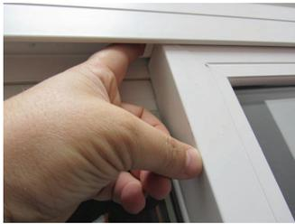
2. Desliza el sash para cerrar la ventana, y con su dedo busque la pieza de la misma pista en la esquina opuesta del mismo sash. Deslice esta pieza lejos del sash en la dirección de apertura.
