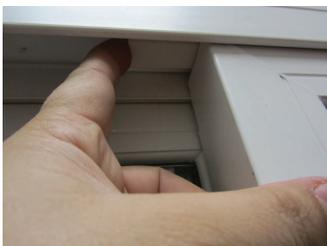
3. Deslice el sash cerrada, y deslice la otra pieza de la pista y colóquelo directamente sobre el sash cerrado.
