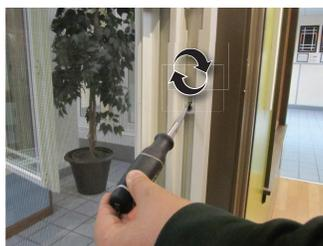
8. Estacionando zapato de equilibrio en posición abierta: utilice un desarmador de cabeza plana para estirar del zapato de equilibrio reculada a la misma altura que el lado opuesto y gire la palanca hacia "posición abierta" para estacionarla
