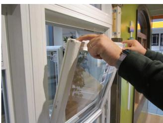
2. Tire de los pestillos de inclinación en ambos lados mientras inclina el marco hacia adentro
