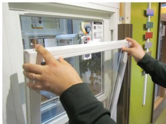
4. Presione los pestillos de inclinación en ambos lados mientras inclina el marco hacia adentro
