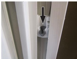
7. Asegúrese de que ambos zapatos de equilibrio estén estacionados y no retrocedidos por completo. Si el freno no se enganchó correctamente, vea el procedimiento para "estacionar EL ZAPATO de equilibrio en posición"
